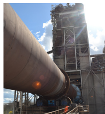
Producția de ciment
