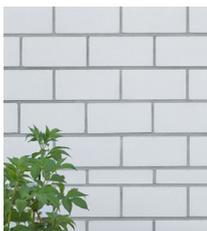
Maçonnerie en silicate de calcium
